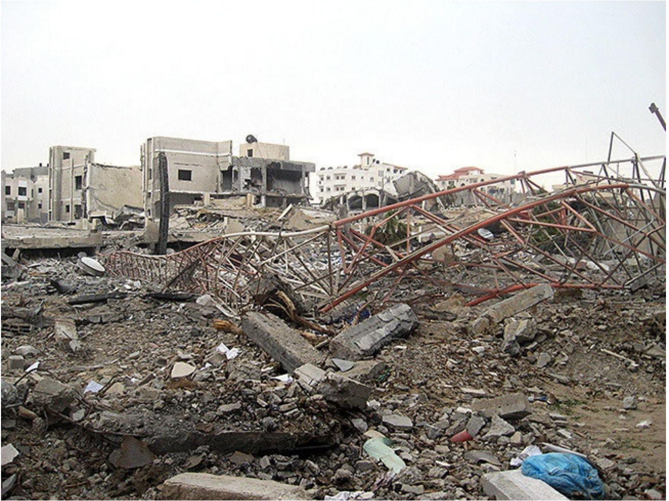
Dstrucción de un barrio residencial tras la Operación Plomo Fundido.
